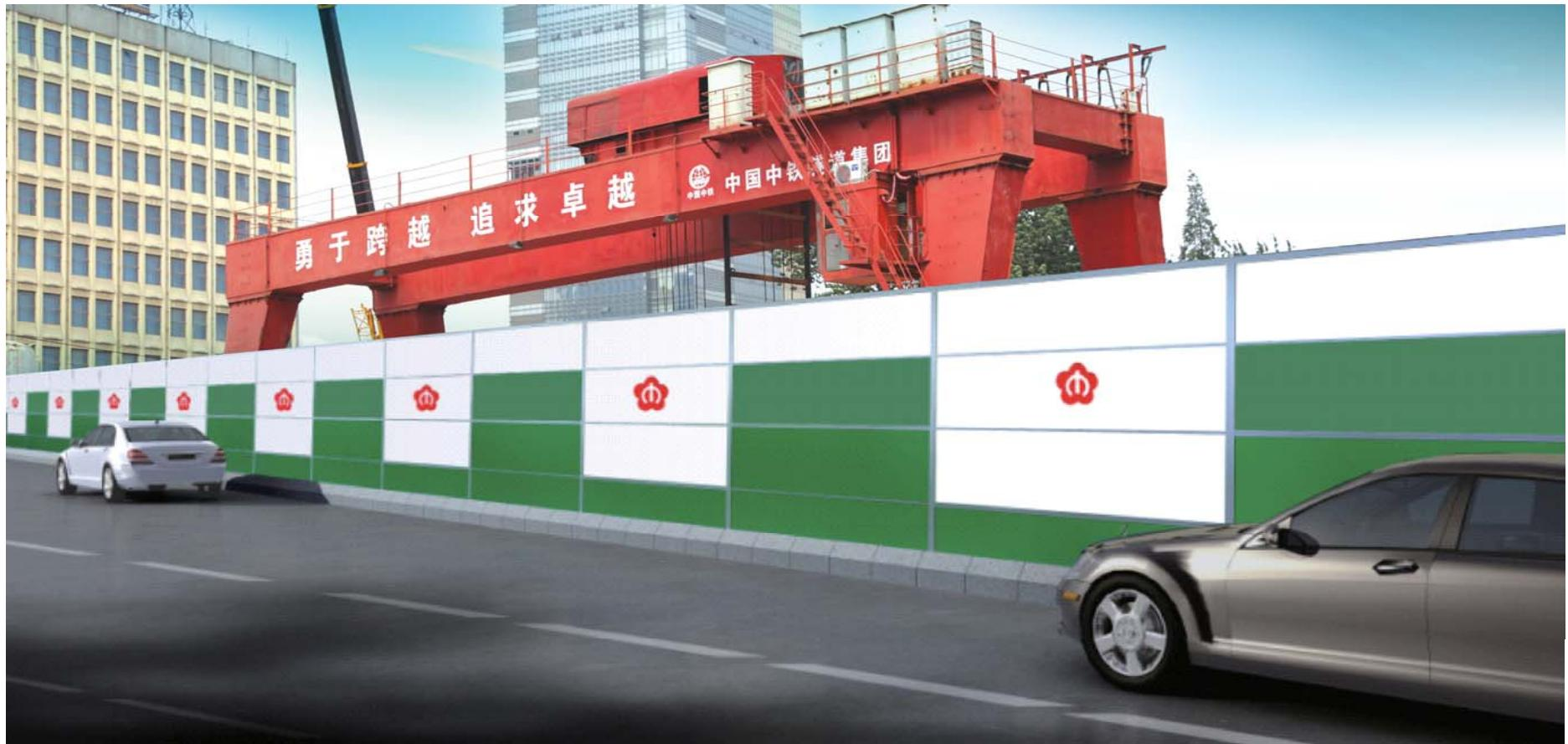
**基本要求：**围挡高度为2.6m；上部结构采用钢结构、夹芯板，表面做防锈处理；基座高度为30cm，采用砖砌，水泥砂浆粉刷；围挡立柱入地400mm以上。
