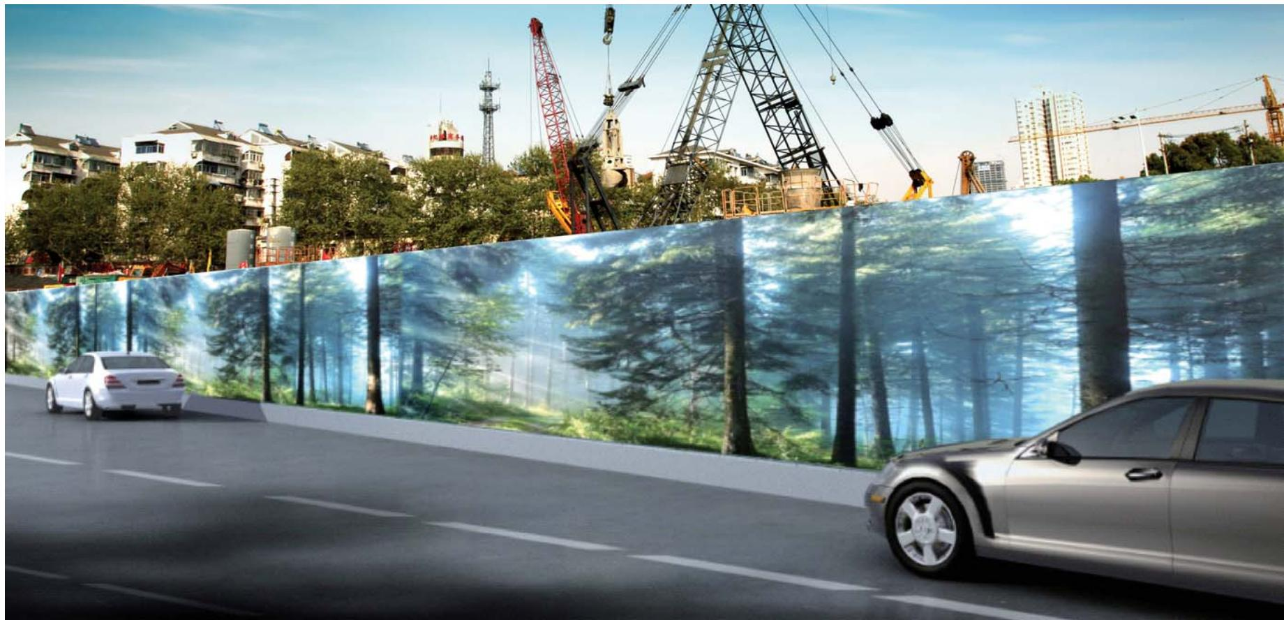
**基本要求：**围挡高度为3.5m；主体结构采用钢结构，表面做防锈处理；基座采用砖砌筑，表面水泥砂浆粉刷并涂刷涂料或贴面砖。围挡画面以介绍本施工项目和公益宣传为主。
