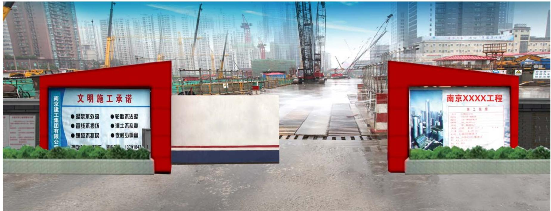
**基本要求：**宽度不小于6000mm,高度不小于3500mm；门上应有施工企业名称；大门外侧应设置符合要求的“六牌一图”，牌图内容真实准确。
