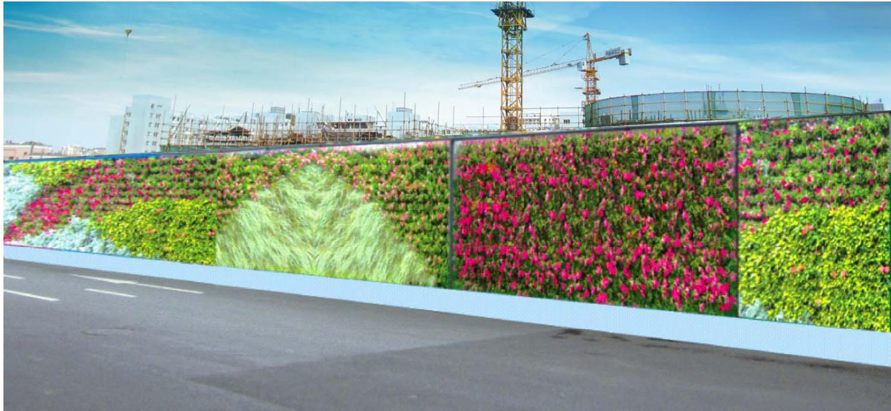
**基本要求：**围挡高度为2.5m；基座高度0.5m；主体结构采用砖砌，水泥砂浆粉刷墙面，垂直墙面镶嵌花草。
