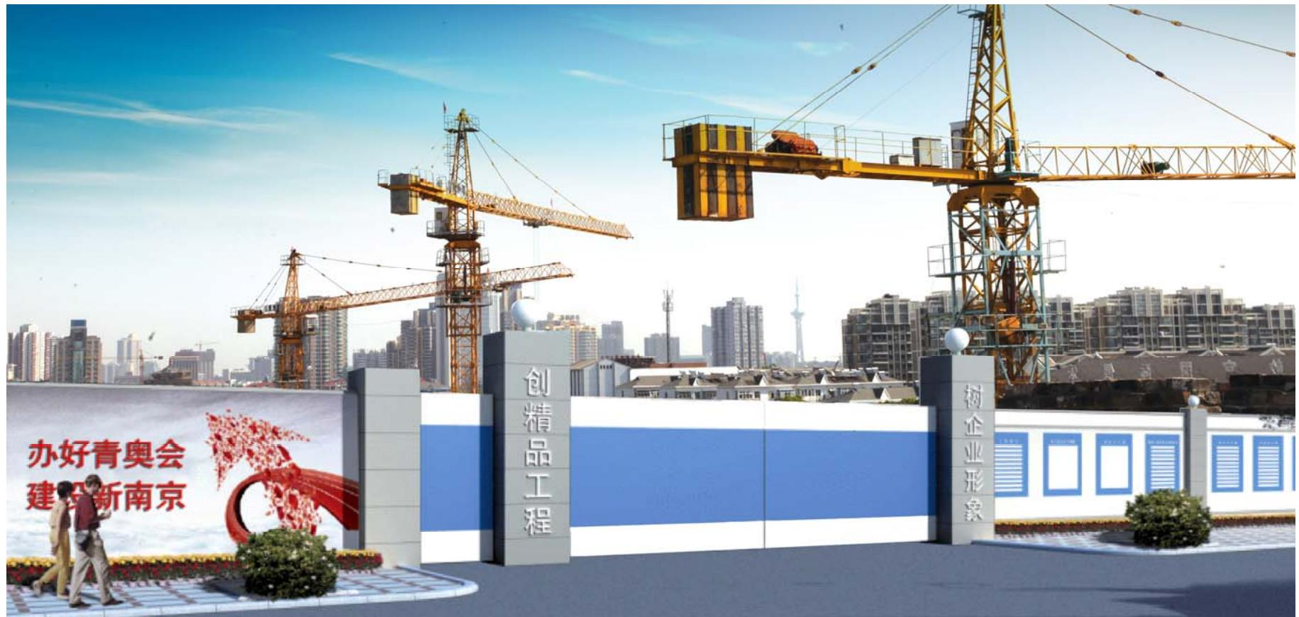
**基本要求：**宽度不小于6000mm,高度不小于3500mm；门上应有施工企业名称；大门外侧应设置符合要求的“六牌一图”，牌图内容真实准确。
